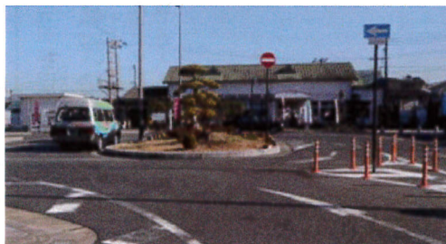
南部駅前（ロータリーになっている）
